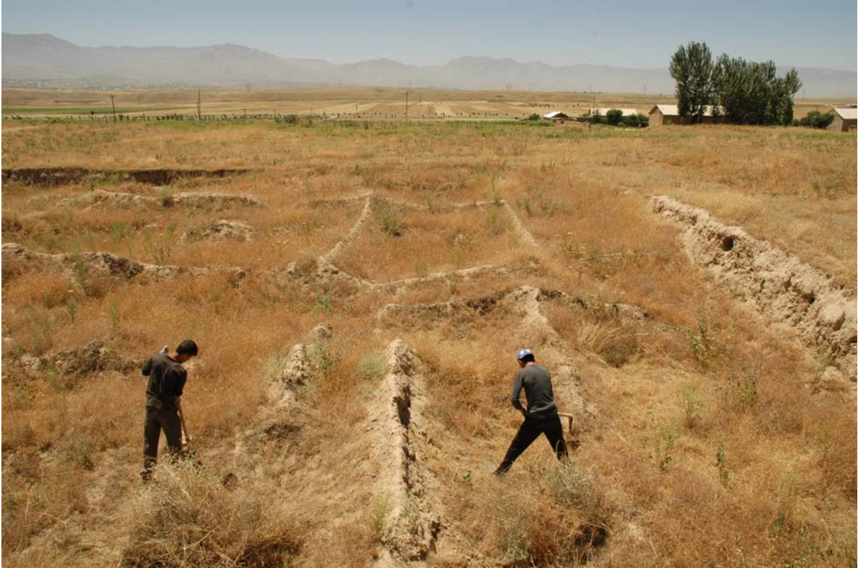
Secteur 5, avant travaux
